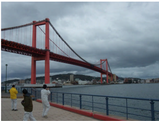
写真-4 若戸大橋全景(戸畑側) Photo-4 Wakato Bridge
