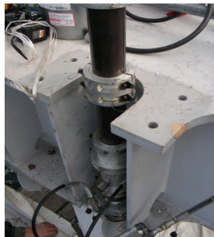
写真-2 防錆材の内部充填
