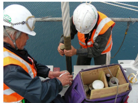
写真-3 外部防食テープ巻付け
