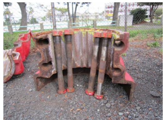
写真-6 バンドボルト取り替え Photo-6 Exchange of cable band bolts
