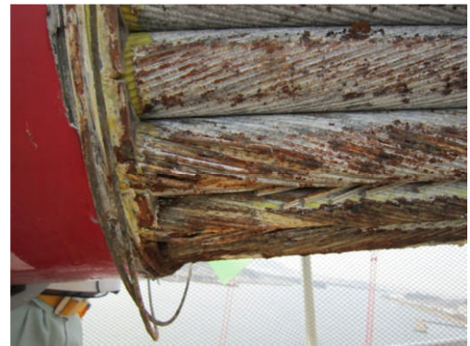
写真-5 主ケーブル調査 Photo-5 Main cable investigation
