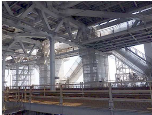
長大橋塗替塗装(瀬戸大橋)
