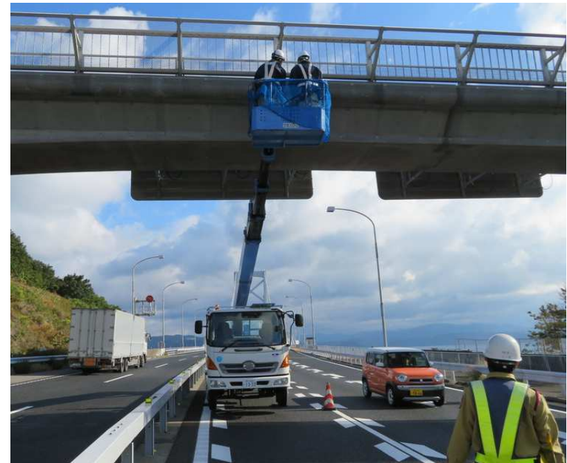
跨道橋点検(徳島県受託)
