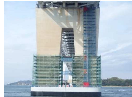
耐震補強(瀬戸大橋/岩黒島橋)
