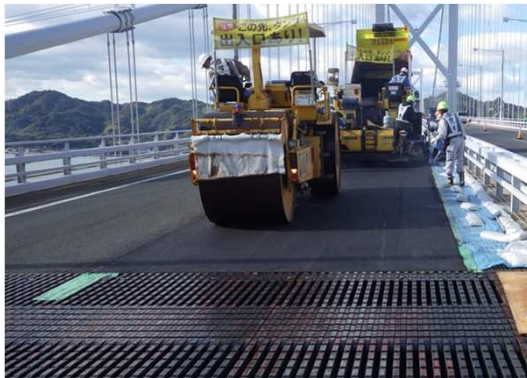
舗装補修(西瀬戸自動車道)
