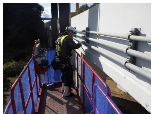
点検状況（電気通信施設）
