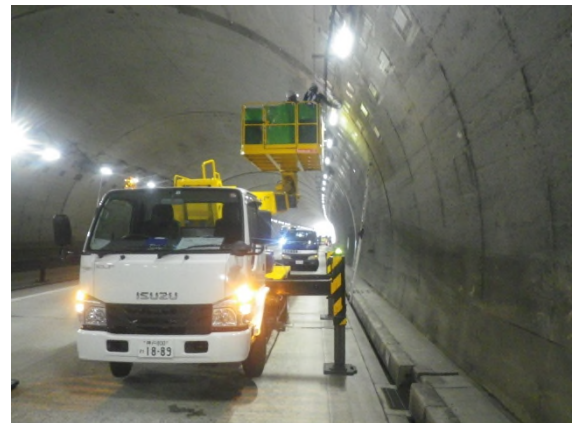
緊急対応（目地部剥落対策）
