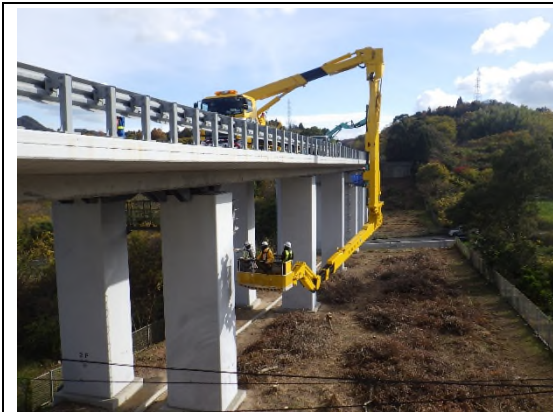
点検状況（土木）
