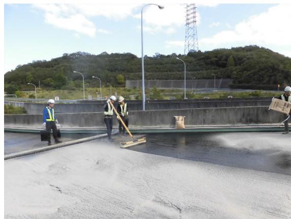
舗装補修工事（床版防水工）
