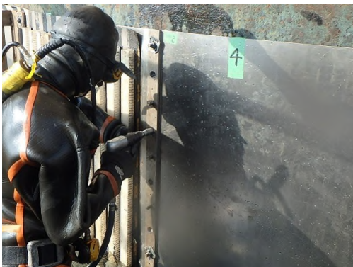
大鳴門橋多柱基礎防食実施状況
