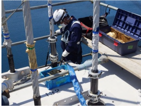
吊橋ハンガーロープ定着部の補修状況 (一般国道 28 号 大鳴門橋)
