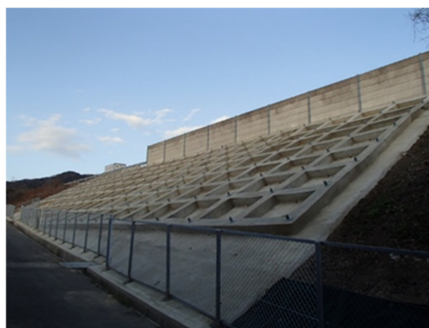
土構造物 盛土のり面補強
