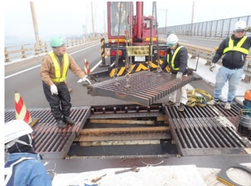
瀬戸大橋伸縮装置補修状況
