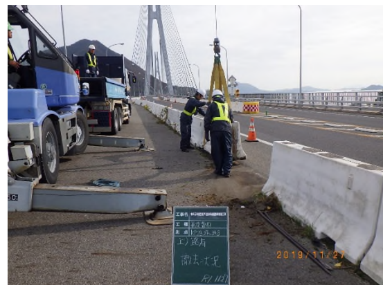
ポリエチレン製防護柵取替
