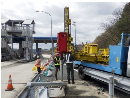
ガードレール取替
