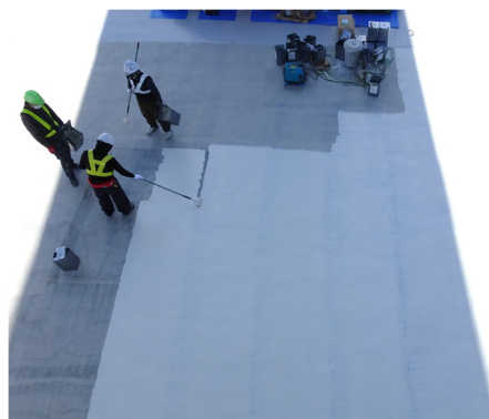
主塔基礎の塩害対策(天端) (一般国道317号 来島海峡第三大橋)
