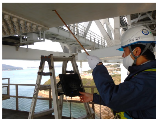
ファイバースコープによる桁内面点検
