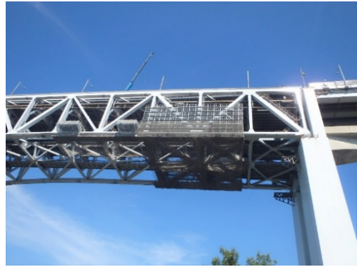
大鳴門橋局部補修塗装実施状況
