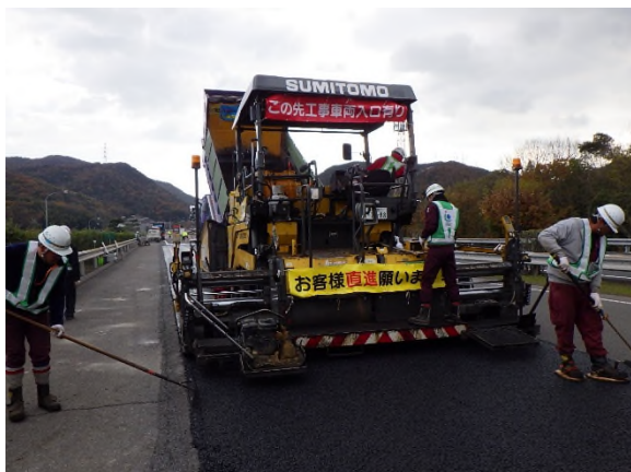
舗装補修工事（切削オーバーレイ工）
