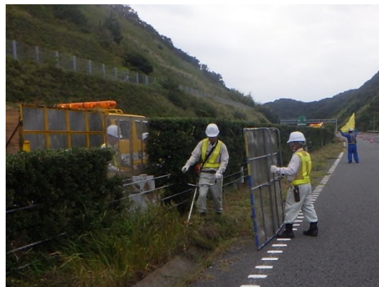
植栽管理（中央分離帯草刈り）
