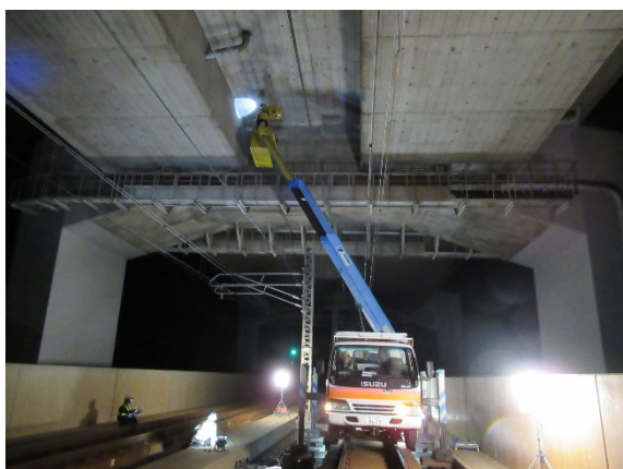
JR軌道上高架橋の打音点検
