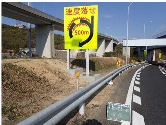
急カーブ注意喚起看板設置
