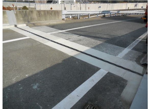
伸縮装置取替
