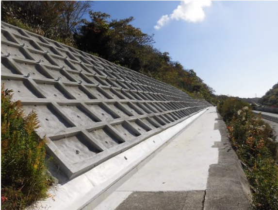
のり面防災対策（のり枠工）
