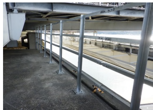
管理路（落下防止柵）補修 (一般国道 317 号 因島大橋)
