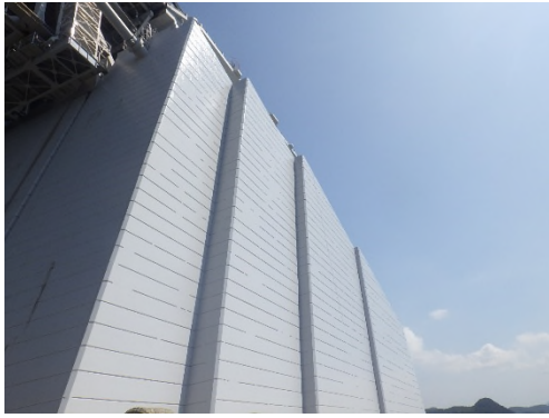
大鳴門橋コンクリート補修完了
