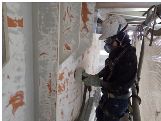
塗替塗装状況 (一般国道 30 号 瀬戸大橋)
