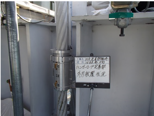
瀬戸大橋ハンガーロープ補修状況
