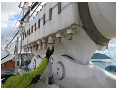
ケーブルバンドボルトキャップの交換 (一般国道 317 号 来島海峡第二大橋)
