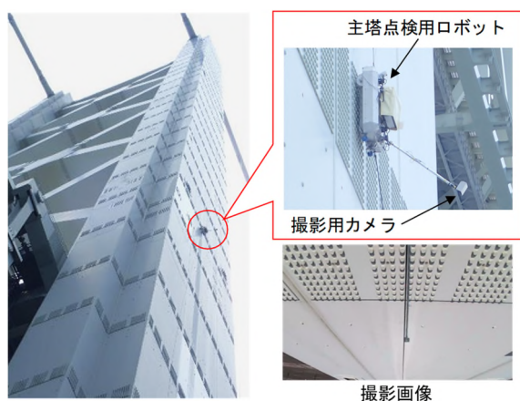
主塔点検用ロボットの検討
