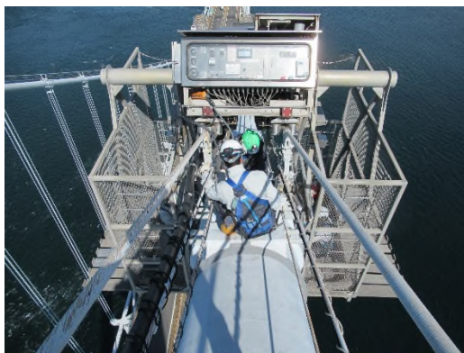
点検状況（長大橋）
