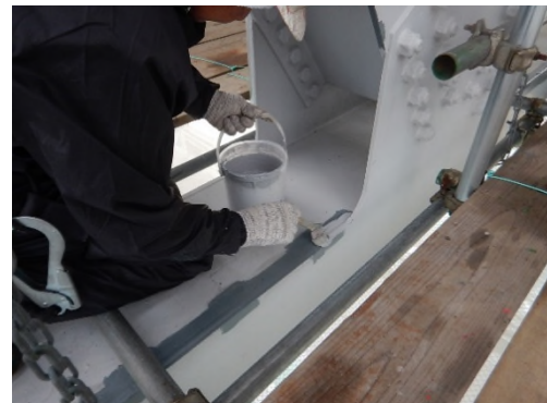
大鳴門橋局部補修塗装実施状況
