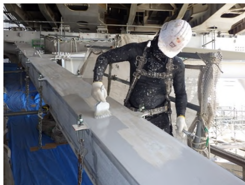
塗替塗装状況 (一般国道 30 号 瀬戸大橋)
