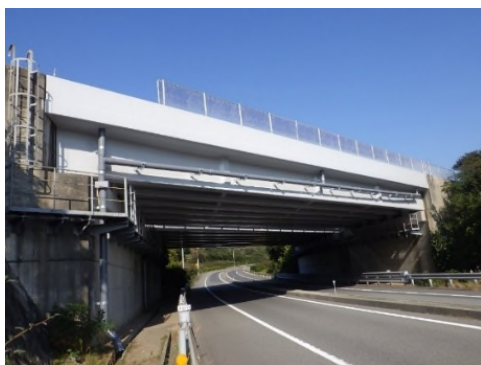
橋梁（桁）の表面被覆工施工状況
