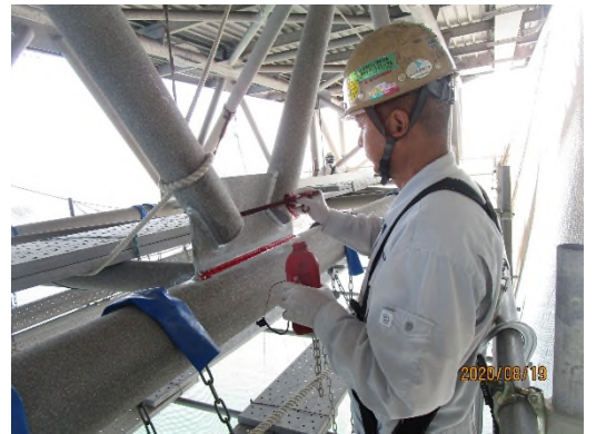
点検状況（機械設備）
