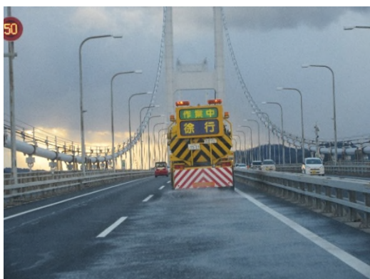
凍結防止剤散布状況
