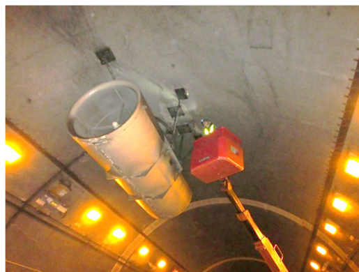
点検状況（機械設備）
