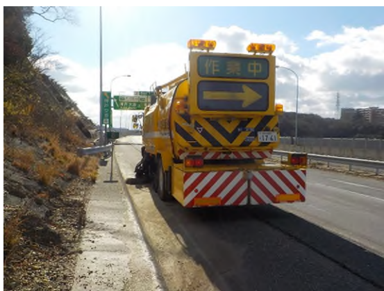
清掃作業（路面清掃）
