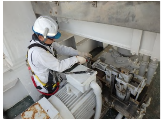
点検状況 (機械設備)
