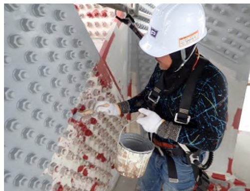
塗替塗装状況 (一般国道 30 号 瀬戸大橋)
