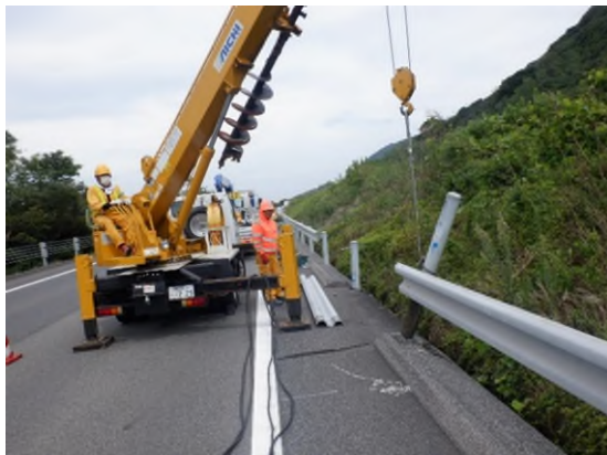
ガードレール取替
