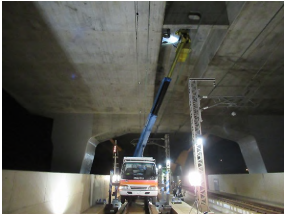
JR軌道上高架橋の打音点検
