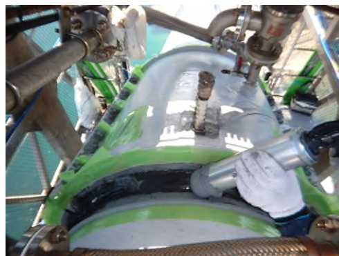
送気カバーシール補修状況 (一般国道 28 号 大鳴門橋)
