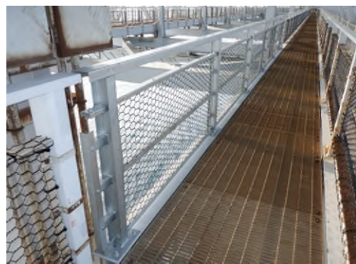
管理路(支柱・金網)補修 (一般国道 28 号 大鳴門橋)
