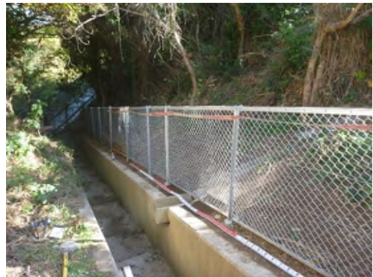
立入防止柵取替
