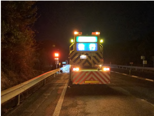
凍結防止剤散布状況
