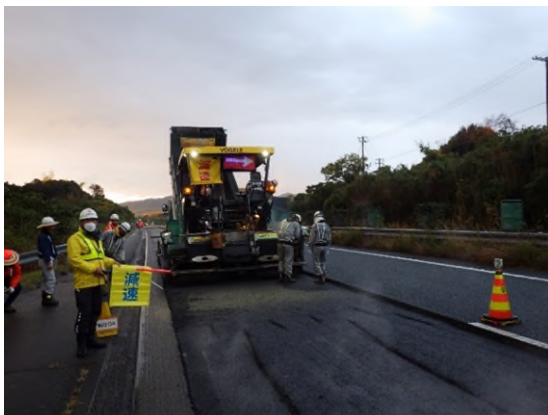
舗装補修工事 (切削オーバーレイ工)
