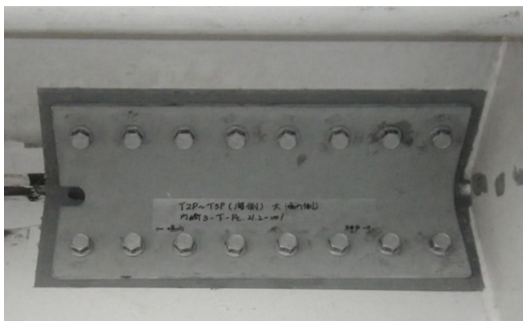
鋼床版下面からの亀裂補修方法
