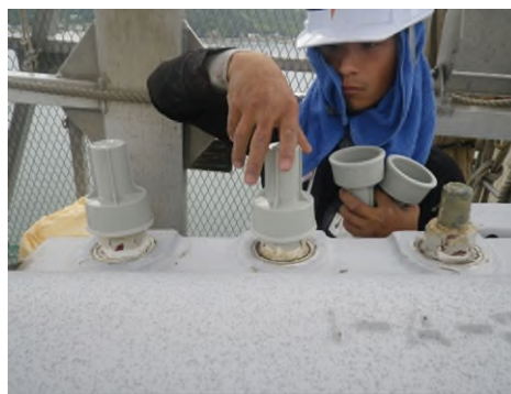
ケーブルバンドボルトキャップの交換 (一般国道 317 号 来島海峡第一大橋)
