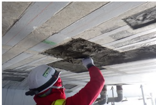
道路桁の塩害対策(電気防食) (一般国道28号 大鳴門橋)
