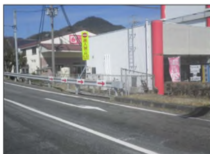
出入口部誤進入対策 (進入禁止板・矢印版)
