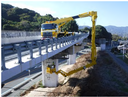
点検状況 (土木)
