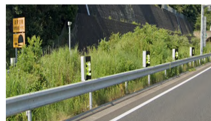
防眩式逆走注意喚起標示注意喚起標示 (逆走方向で「逆走中！」標示)
