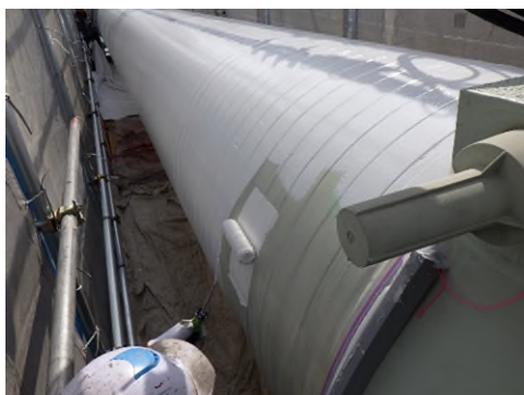
主ケーブル補修塗装状況 (一般国道 28 号 明石海峡大橋)
