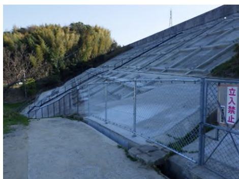
土構造物 盛土のり面補強（鳴門）
