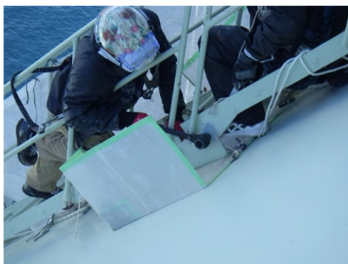
管理路(主塔斜材部)補修 (一般国道 28 号 明石海峡大橋)
