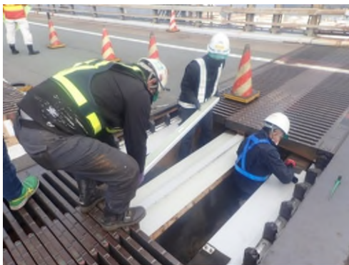
大型伸縮装置の補修 (一般国道 30 号 瀬戸大橋)
