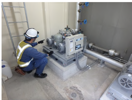
点検状況 (機械設備)
