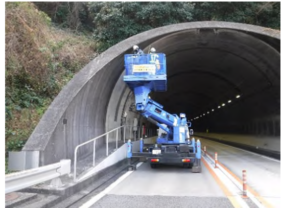
点検状況(土木)
