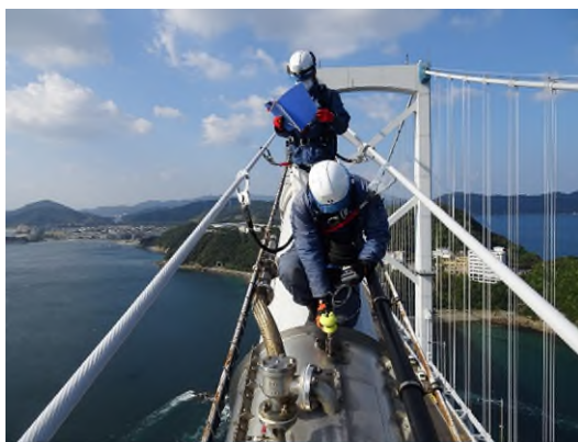
点検状況 (長大橋)
