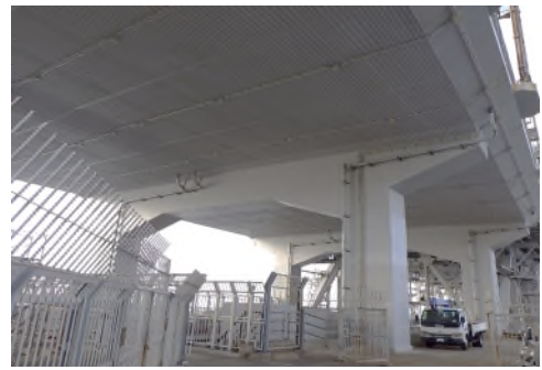
大鳴門橋コンクリート電気防食完了
