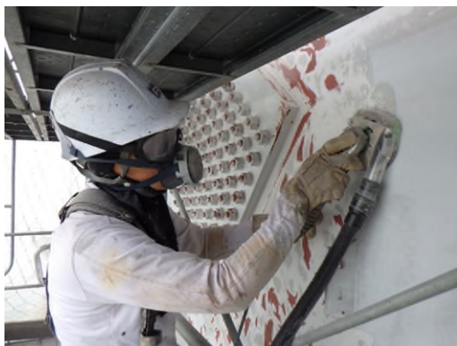
塗替塗装状況 (一般国道 30 号 瀬戸大橋)
