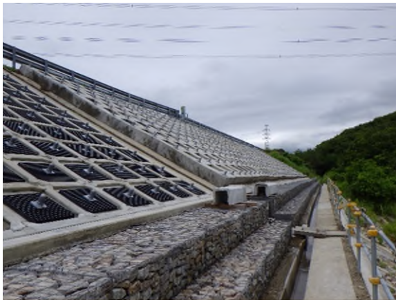
のり面防災対策（のり枠工）
