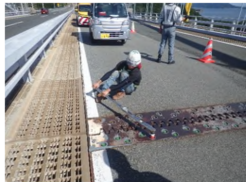
鋼床版伸縮装置の補修 (一般国道 317 号 因島大橋)
