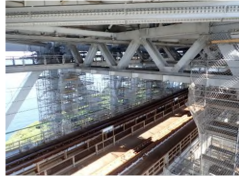
瀬戸大橋 塗替塗装実施状況
