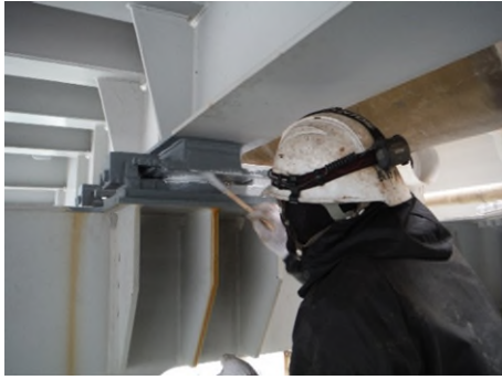
大鳴門橋局部補修塗装実施状況
