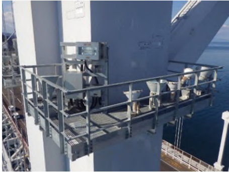
大鳴門橋 主塔管理路更新完了
