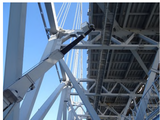
点検状況 (長大橋)
