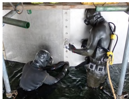
大鳴門橋多柱基礎防食実施状況
