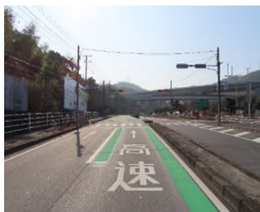
一般道誤進入対策 (路面標示)
