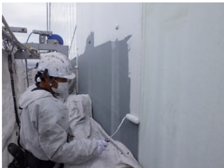
明石海峡大橋 主塔補修塗装実施状況
