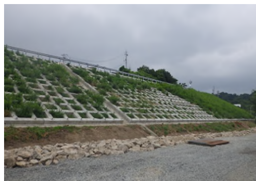
土構造物 盛土のり面補強（尾道）
