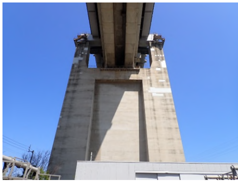
瀬戸大橋 コンクリート剥落対策完了
