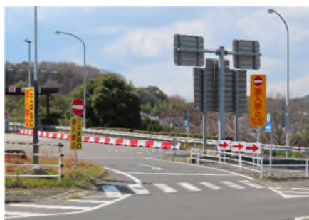
出入口部誤進入対策 (進入禁止板・矢印板)
