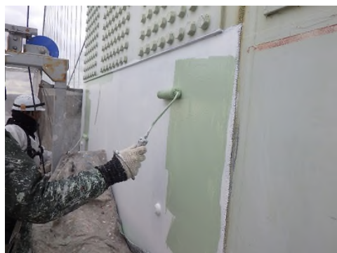
明石海峡大橋 主塔補修塗装実施
