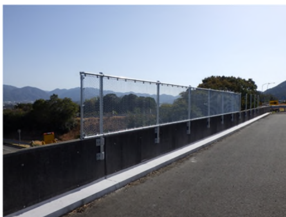
落下物防止柵設置工事
