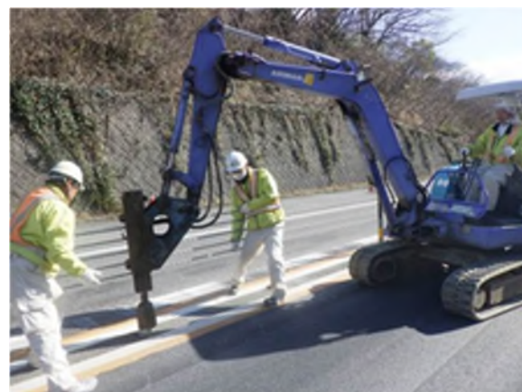
中分ワイヤロープ復旧工
