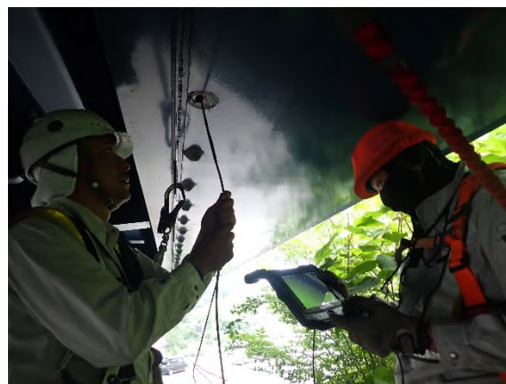
ファイバースコープによる桁内面点検
