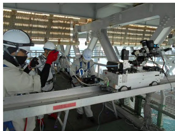
赤外線サーモグラフィによる疲労亀裂調査
