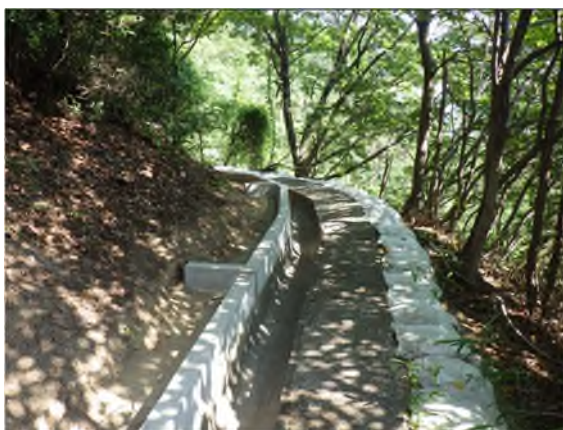
土構造物 のり面の排水溝改良
