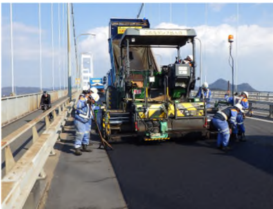
舗装補修工事（切削オーバーレイ工）
