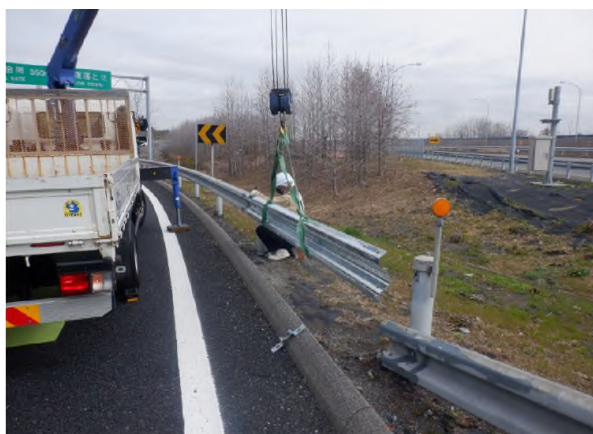
ガードレール復旧工
