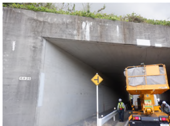
はく落対策工事（C-BOX）
