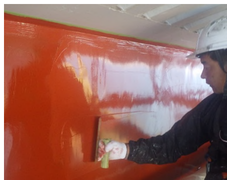
大鳴門橋 1A コンクリート補修状況
