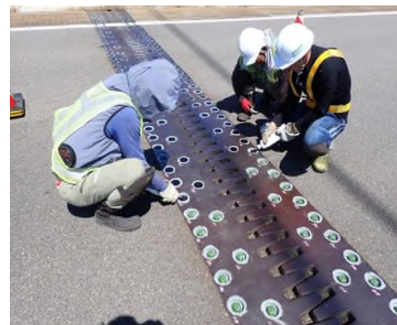
鋼床版伸縮装置の補修 (一般国道30号 瀬戸大橋)
