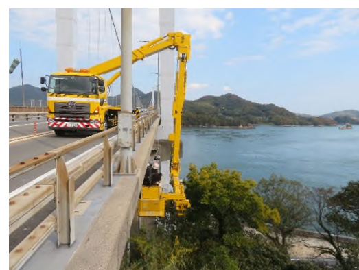
点検状況（長大橋）
