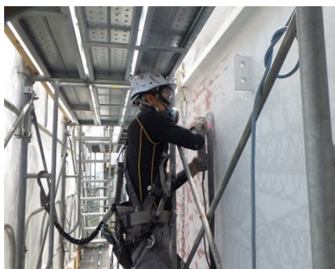
塗替塗装状況 (一般国道 30 号 瀬戸大橋)
