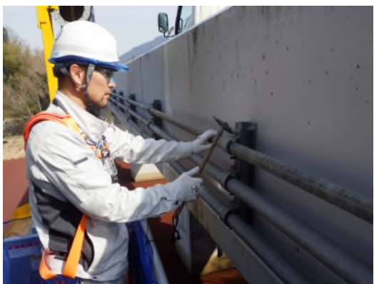
点検状況（電気通信施設）
