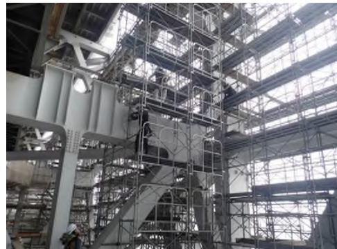
瀬戸大橋 塗替塗装実施状況
