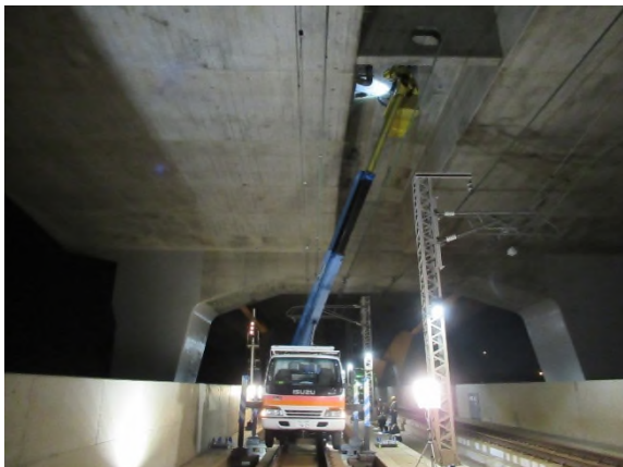
JR軌道上高架橋の打音点検
