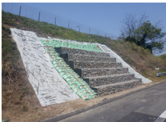
のり面補修工事（ふとんかご工）
