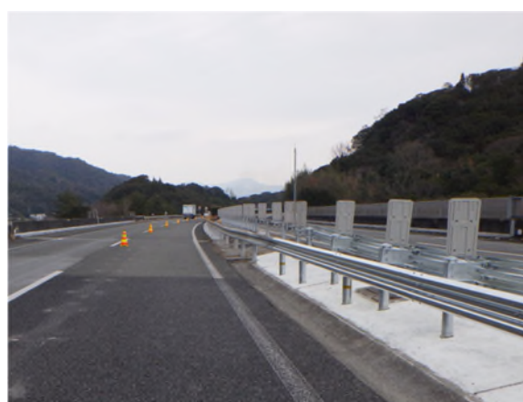
防護柵改良工事
