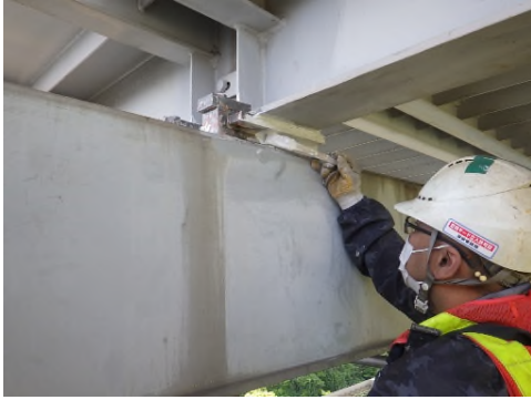
因島大橋局部補修塗装実施状況
