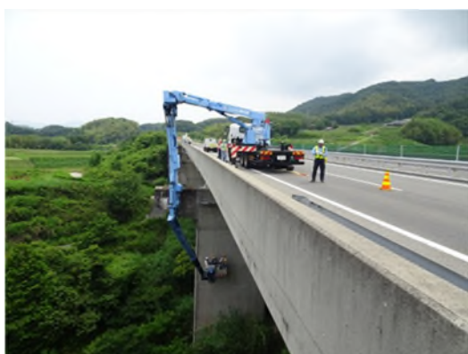
点検状況（土木）
