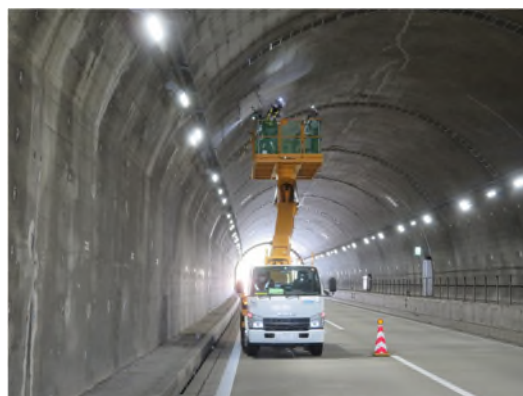
点検状況（土木）
