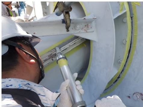
ケーブルバンドシール補修状況 (一般国道 317 号 大島大橋)
