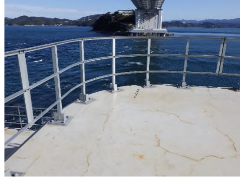
大鳴門橋 主塔基部管理路更新完了
