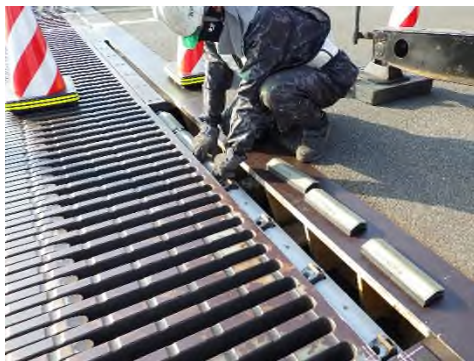
大型伸縮装置の補修 (一般国道30号 瀬戸大橋)
