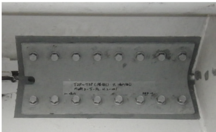
鋼床版下面からの亀裂補修方法
