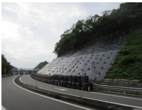
因島北 IC ランプ部（応急復旧時）
