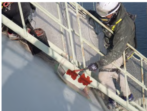
管理路(主塔斜材部)補修 (一般国道28号 明石海峡大橋)
