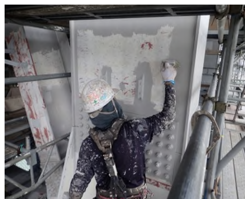
塗替塗装状況 (一般国道 30 号 瀬戸大橋)
