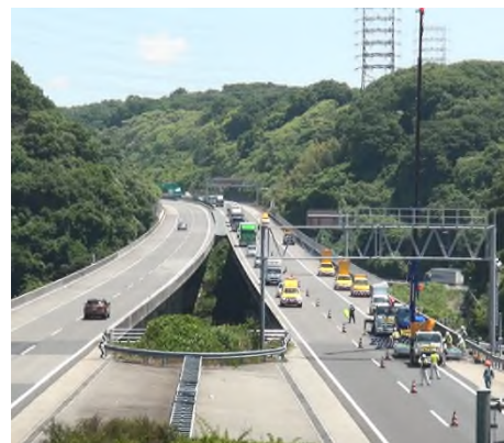
低速走行規制による大型標識撤去作業(左が撤去中、右が撤去完了)
