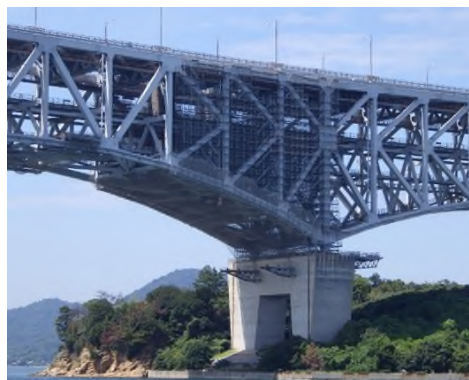
補剛桁の塗替塗装足場 (一般国道30号 瀬戸大橋)
