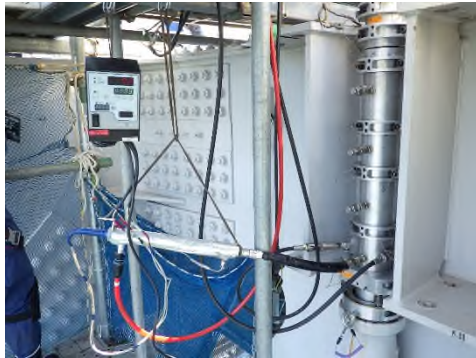
吊橋ハンガーロープの内部充填完了 (一般国道30号 瀬戸大橋)
