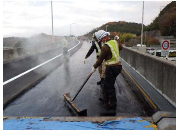
舗装補修工事（床版防水工）
