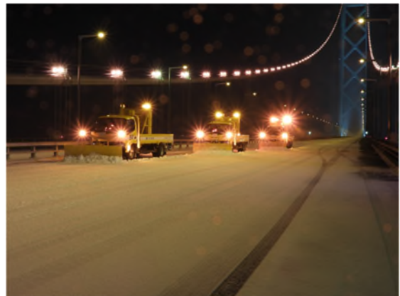
除雪状況（明石海峡大橋）
