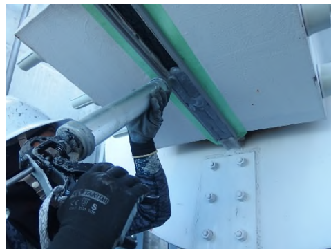
ケーブルバンドシール補修状況 (一般国道 30 号 南備讃瀬戸大橋)
