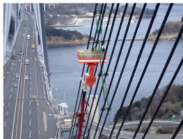
斜ケーブル制振ロープ補修 (瀬戸中央自動車道)
