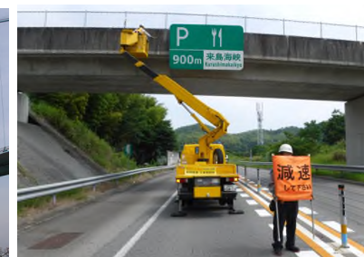
跨道橋点検 (愛媛県/近見跨道橋)
