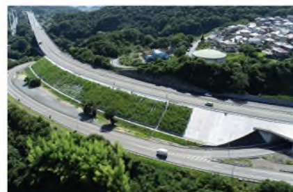
のり面安定対策 (西瀬戸自動車道)
