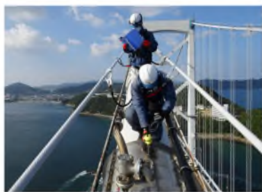
主ケーブル点検 (神戸淡路鳴門自動車道)
