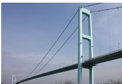
長大橋技術支援 (広島県/芸芸灘大橋)
