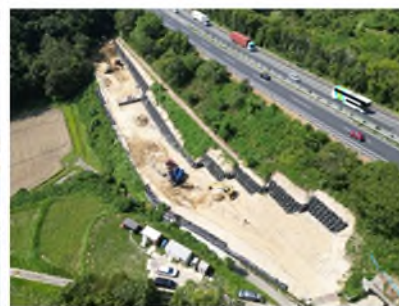
のり面安定対策 (神戸淡路鳴門自動車道)
