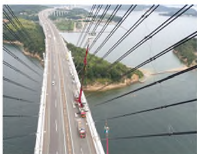
斜張橋ケーブル補修 (瀬戸中央自動車道)
