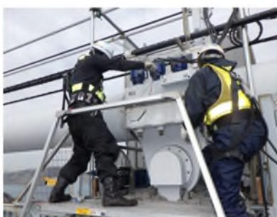
主ケーブル補修 (西瀬戸自動車道)
