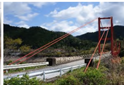
長大橋技術支援 (高知県/魚梁瀬大橋)
