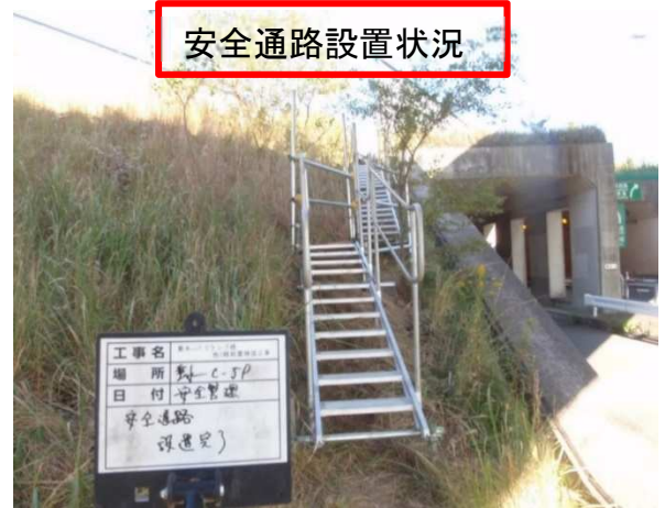
写真—3. 4安全通路設備の設置状況
