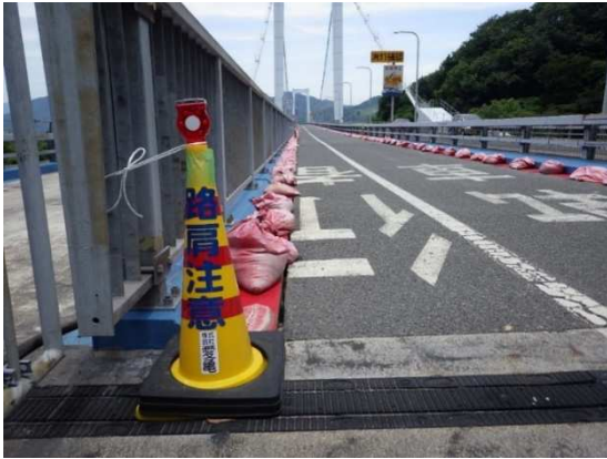
写真—1. 原自歩道の路肩養生の工夫
