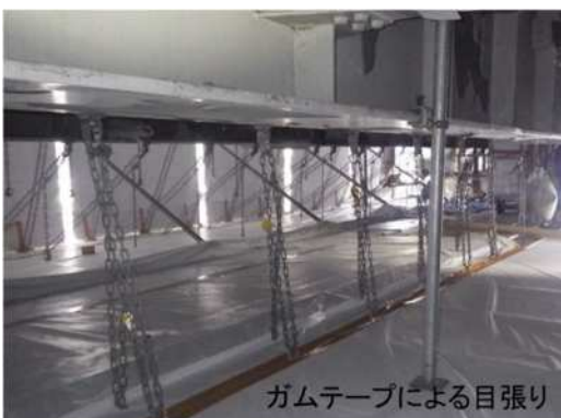
写真—5. 足場内部の養生状況
