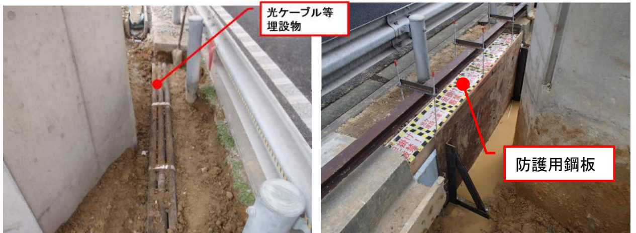
写真—1, 2 光ケーブル等埋設物の近接施工状況
