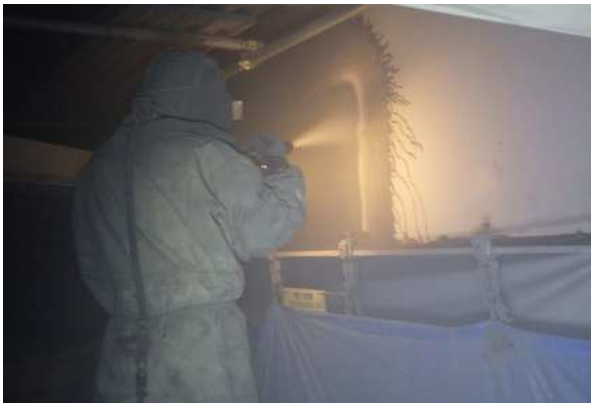
写真—3. 湿式ブラストによる下地処理状況
