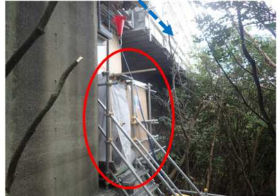
写真—1. 2 鉛含有塗膜対策（クリーンルーム）
