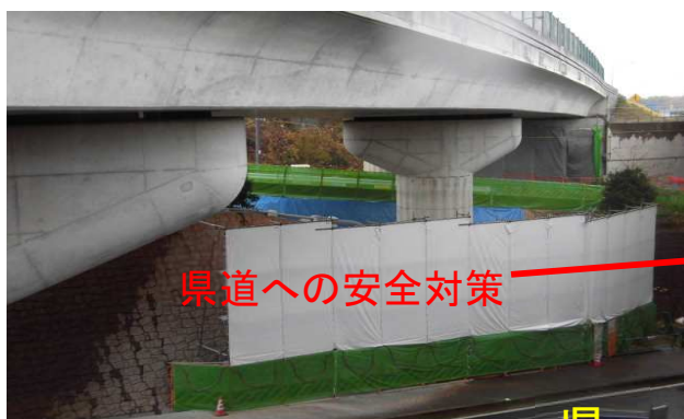
写真—5. 6 県道の近接施工、仮設防護の設置
