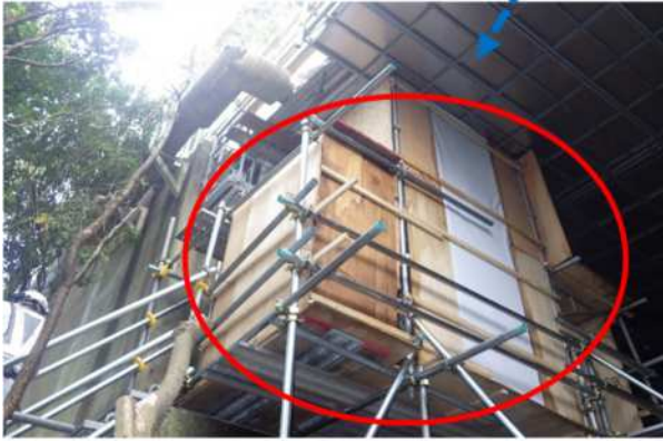
写真—1. 2 鉛含有塗膜対策（クリーンルーム）
