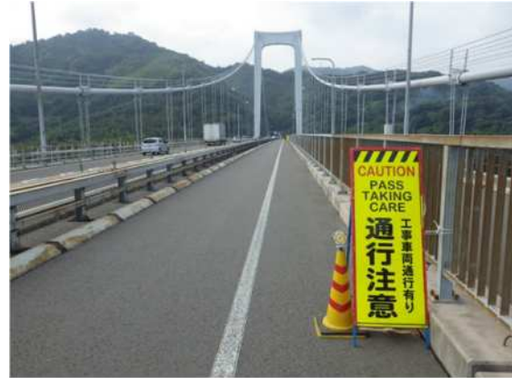
写真—2. 原自歩道の工事看板に英語を併記
