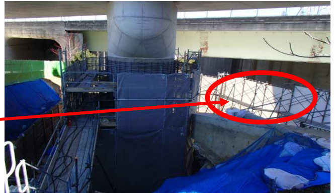
写真—5. 6 県道の近接施工、仮設防護の設置
