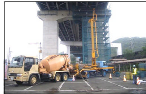
橋梁耐震補強(撫養橋南高架橋)
