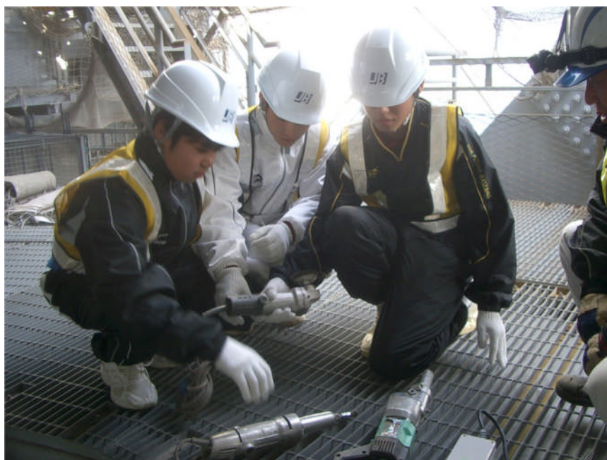
瀬戸大橋塗替塗装現場
