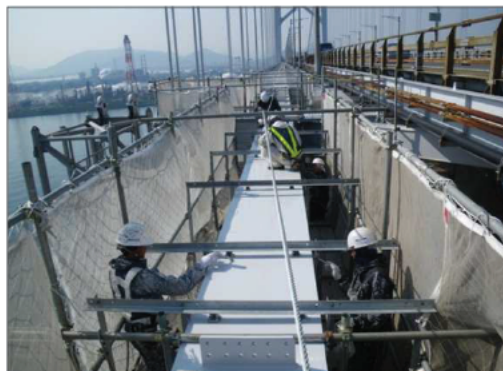
長大橋塗替塗装(瀬戸大橋)
