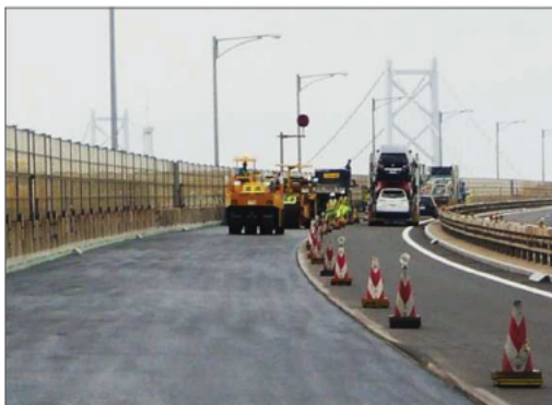
舗装補修(瀬戸大橋)
