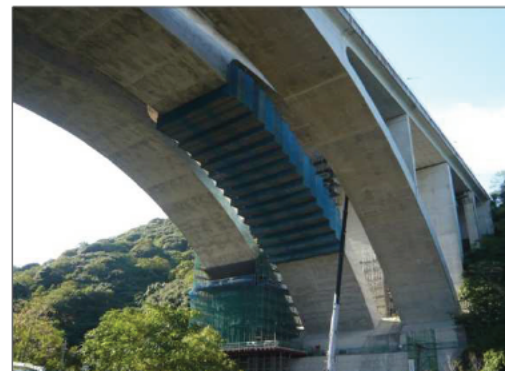
耐震補強(茶間川橋)
