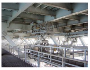
桁内面作業車見学!
