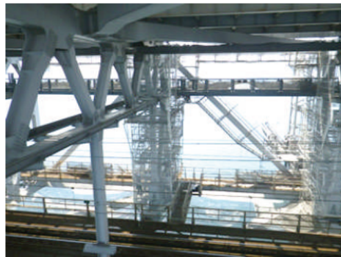
長大橋塗替塗装(瀬戸大橋)
