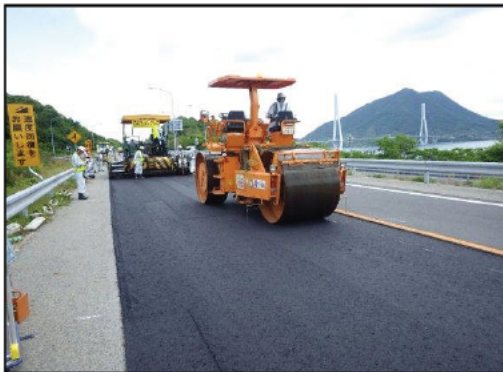
舗装補修(西瀬戸自動車道)
