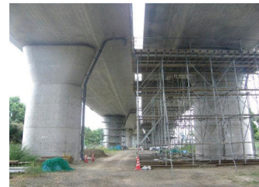
耐震補強(撫養高架橋)
