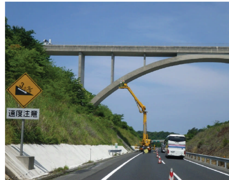
跨道橋(淡路市管理)点検業務
