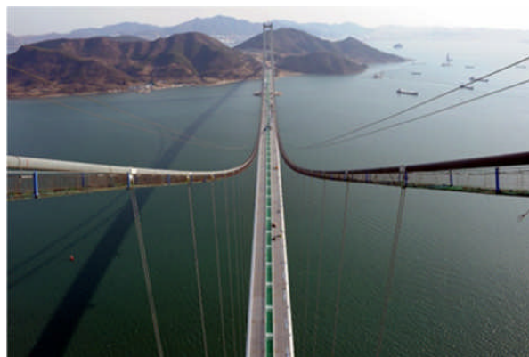
写真－6 補剛桁架設後の塔頂からの全景 Photo.6 View from the top of a tower
