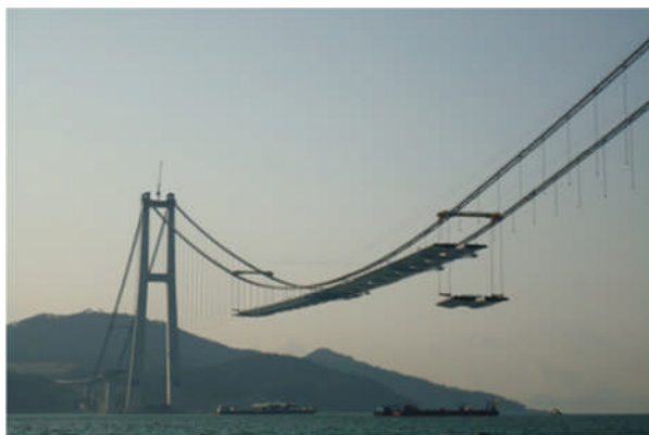
写真－5 補剛桁架設 Photo.5 Erection of stiffening girder
