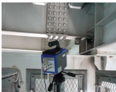
写真-1 赤外線サーモグラフィー装置による計測 Photo.1 Infrared thermography device
