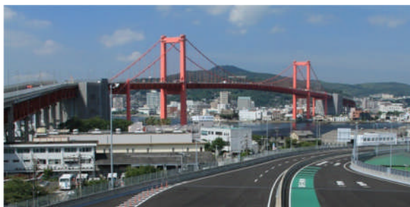
写真-3 若戸大橋 Photo.3 Wakato Bridge
