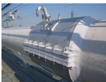
写真-6 排気カバー Photo-6 Exhaust sleeve
