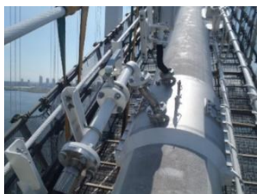
写真-5 送気カバー Photo-5 Injection sleeve
