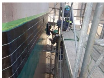
写真-2 繊維シート巻き立て Photo-2 Fiber Sheet Jacketing
