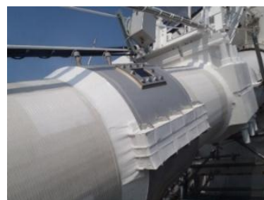
写真-7 モニタリングカバー Photo-7 Monitoring sleeve
