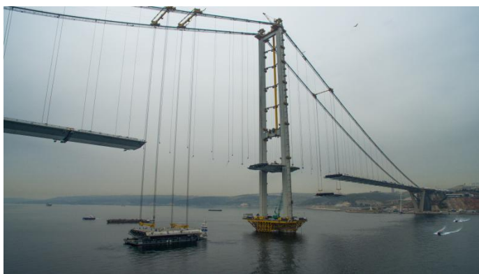
写真-8 補剛桁架設 (2016 年 3 月) Photo-8 Deck Erection in March, 2016
