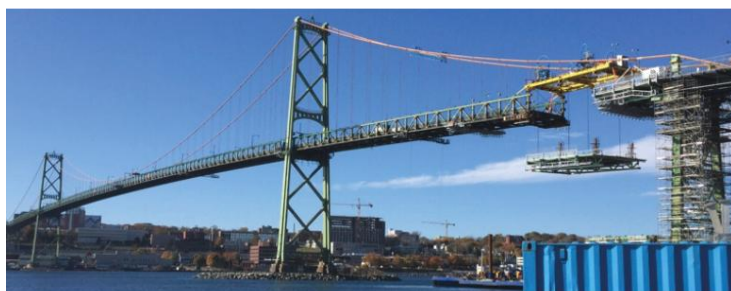
写真-5 架替えの様子 Photo-5 Deck Replacement
