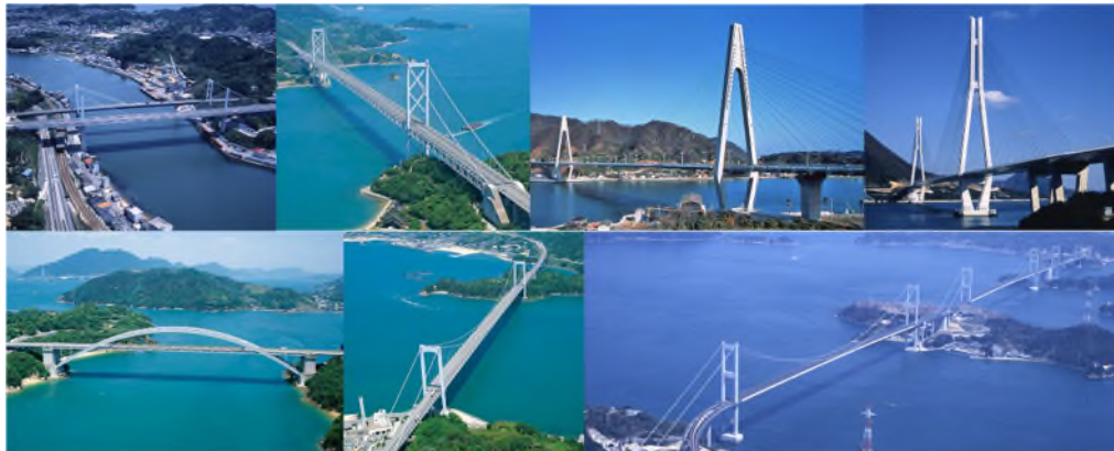
写真-1 しまなみ海道の長大橋
