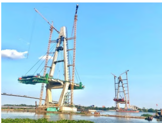
写真-4 第二ミトワン橋の建設状況 Photo 4 Construction of My Thuan 2 Bridge
