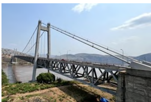
写真-6 マタディ橋 Photo 6 Matadi Bridge
