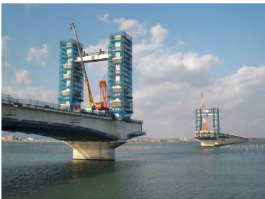
写真-4 東環状大橋
