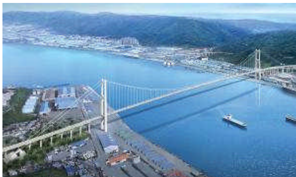
写真 - 7 ウルサンハーバー大橋
