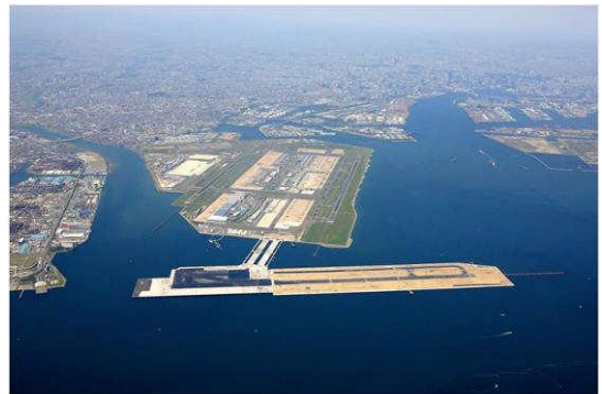
写真-4 羽田空港 D 滑走路
