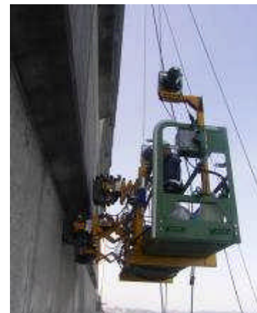
写真-3 真空吸着ゴンドラ (Photo-3 Vacuum-Gripped-Wheel Gondola)
