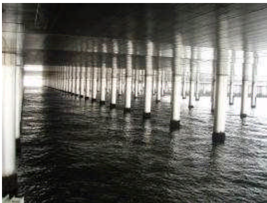
写真-5 チタンカバープレート外観
