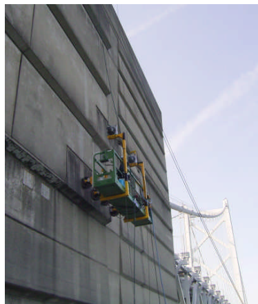
写真-2 真空吸着ゴンドラ (Photo-2 Vacuum-Gripped-Wheel Gondola)
