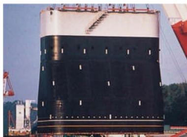
写真-1 来島海峡大橋 3P 鋼製ケーソン (設置時)
