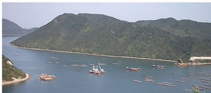
写真-5 日生大橋工事現況写真(2011. 9)
