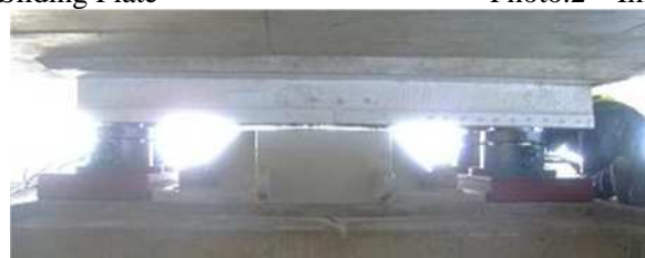
写真-3 ジャッキアップ状況
