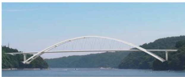
写真-4 大島架橋の完成イメージ (向かって右側が気仙沼市大島)
