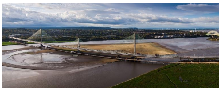
写真-2 マージーゲートウェイ橋の全景 Photo 2 Mersey Gateway Bridge
