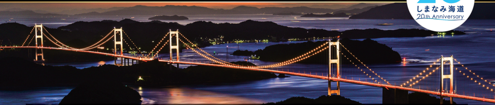
来島海峡大橋 ライトアップカレンダー
