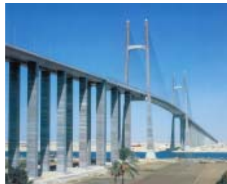
スエズ運河橋 (Suez Canal Bridge) (橋梁と基礎 2001.11 より)
