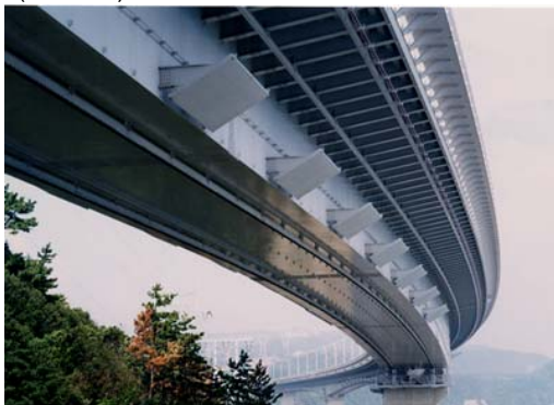
写真-1 下部スカート (Photo-1 Lower Skirt)
