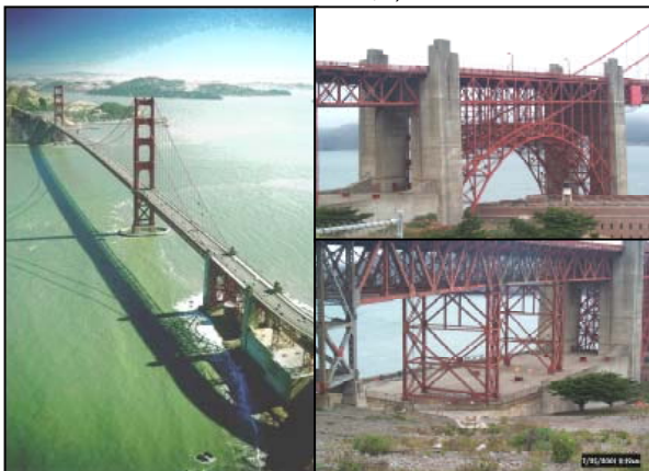
ゴールデンゲート橋の耐震補強 (Golden Gate Bridge Seismic Retrofit)
