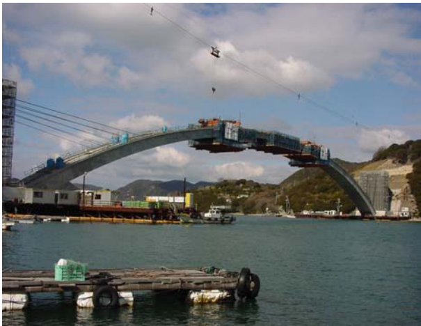
アーチリブ架設状況 (Erection of Arch Rib)
