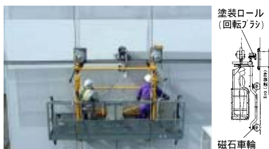
写真-1 塗装装置による塗装作業状況 (Photo.1 Painting robot for tower)
