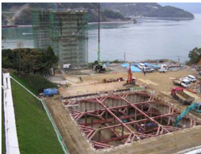
写真-4 4A 施工状況
