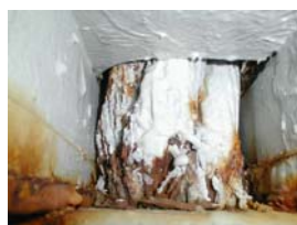
腐食部 (Corrosion)
