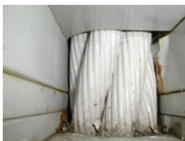
健全部 (No corrosion)
