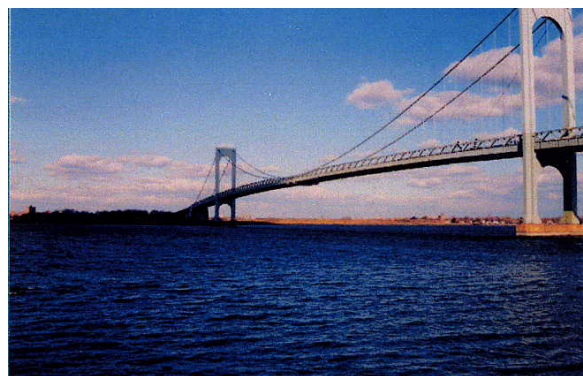
写真-5 トラス撤去前のブロンクスホワイトストーン橋 Photo.5 The Bronx - Whitestone Bridge before the removal of truss girder
