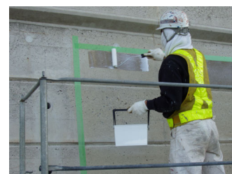
写真-2 塗布状況
