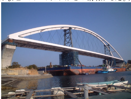
写真-3 位置決めが完了した志摩大橋
