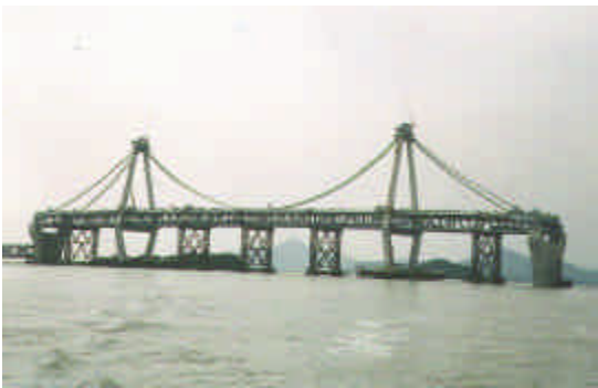
キャットウォーク架設の永宗大橋 (撮影: 岡野哲氏) Cats-walk installation of Youngjong Grand Bridge
