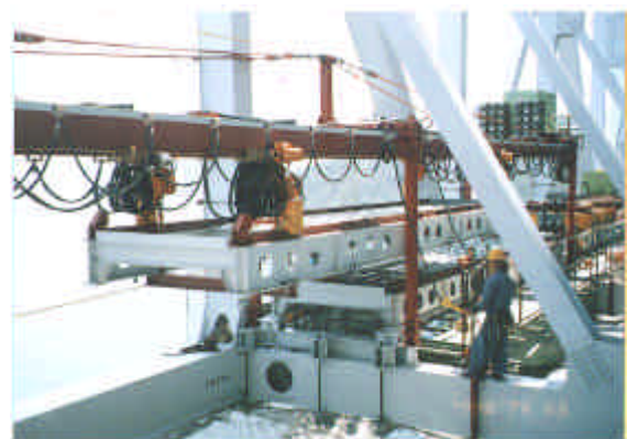
連絡通路の架設状況
