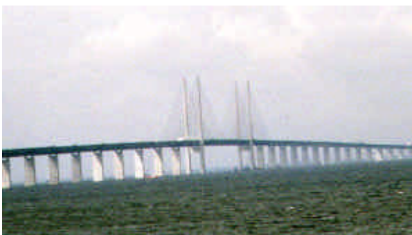
桁架設完了後の全景 (撮影: 吉川章三氏) High bridge
