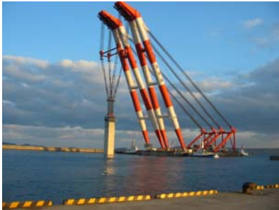
写真-2 海中基礎吊運搬状況
