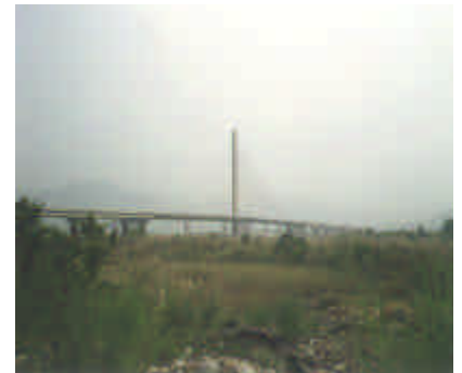
集鹿大橋 Ji Ji Da Bridge
