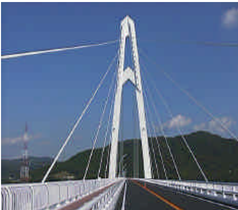
大島大橋 Ohshima Bridge
