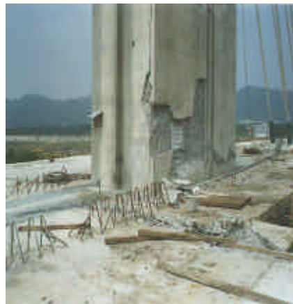
主塔基部 Bottom of main tower
