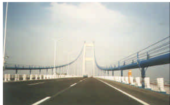
桁上より(在中国 JICA 専門家、栗野純孝氏撮影) View from the deck
