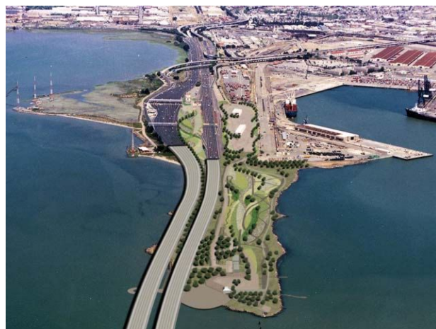
写真-2 オークランドに建設される料金所
