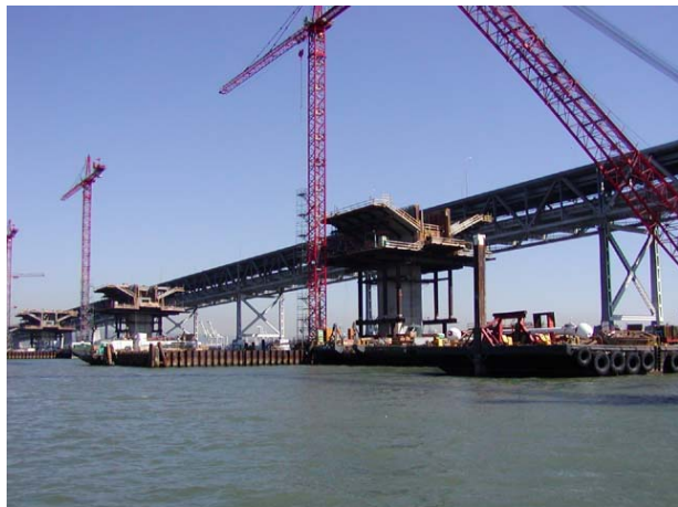
写真-1 スカイウェイの建設 Photo.1 Construction of Skyway Section
