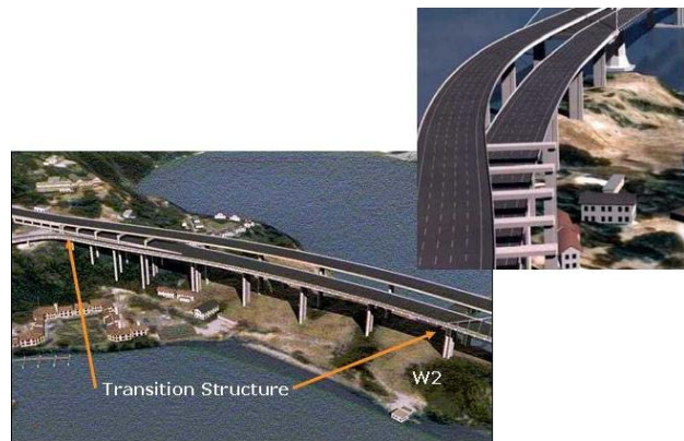
図-6 イェルバブエナ島高架橋の切替部 Fig.6 Transition Structure to new Yerba Buena Island Va.
