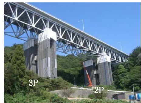
写真-1 高架橋全景
