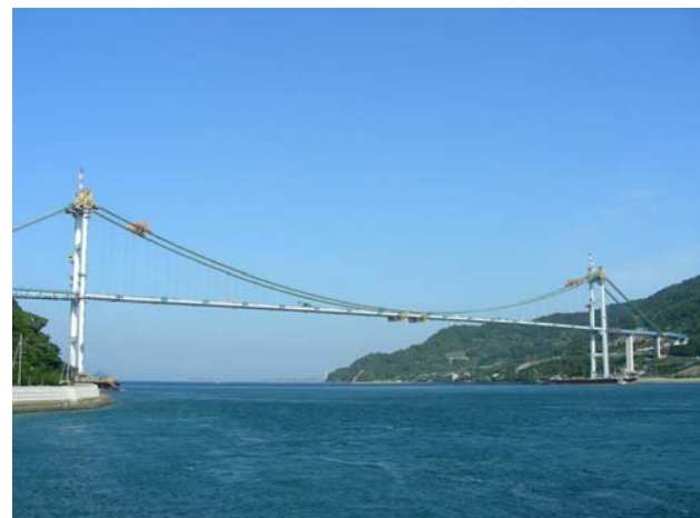
写真-2 桁直下吊り架設終了
