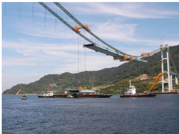
写真-1 桁直下吊り架設
