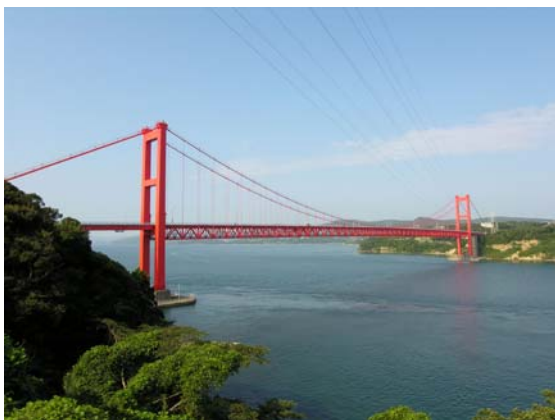
写真-3 平戸大橋(長崎県)
