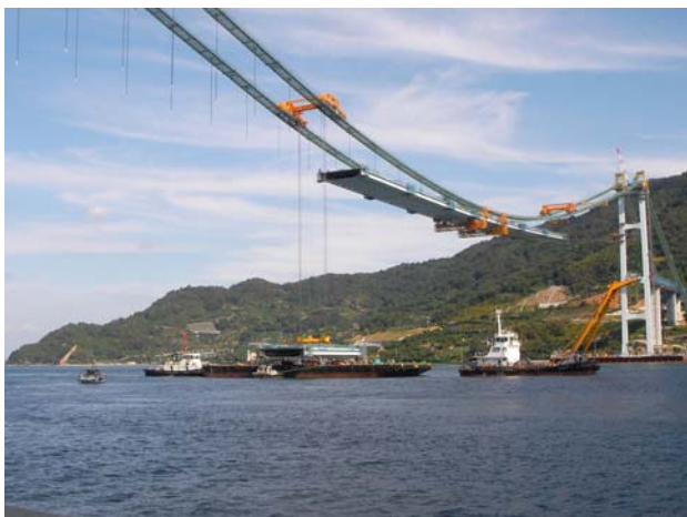
写真-1 桁直下吊り架設
