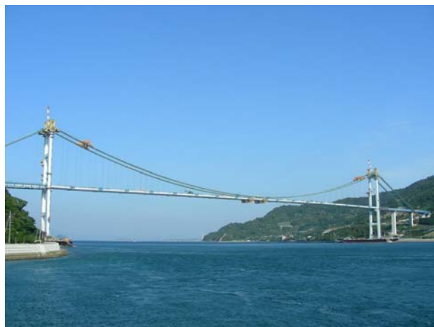
写真-2 桁直下吊り架設終了
