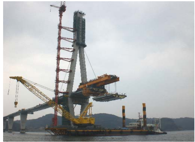
写真-7 中央径間架設状況 (Photo.7 Construction of center span)
