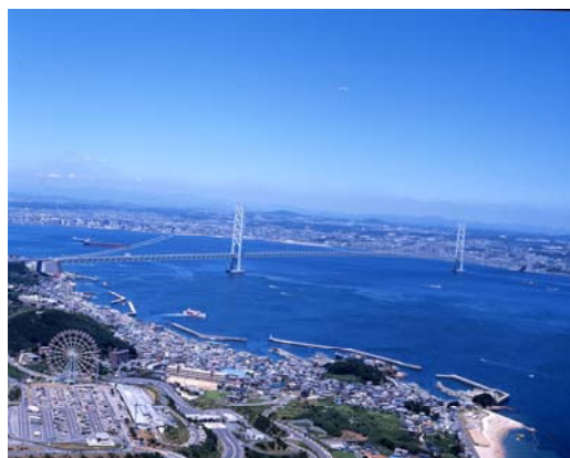
写真-2 明石海峡大橋(供用 10 周年) (Photo.2 Akashi-Kaikyo Bridge (10 th anniversary))
