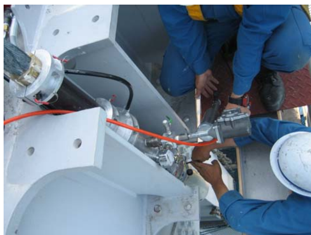
写真-4 ハンガーロープ内部充填工法 (Photo.4 Void filling of suspender)
