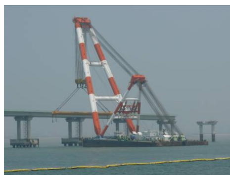
写真-8 高架橋架設用クレーン船
