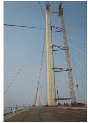
写真-6 上海長江大橋 (Photo.6 Shanghai Yangtze River Bridge)
