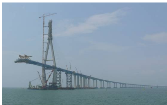
写真-7 建設中の仁川大橋
