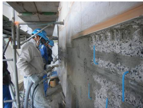
写真-2 断面修復工の状況
