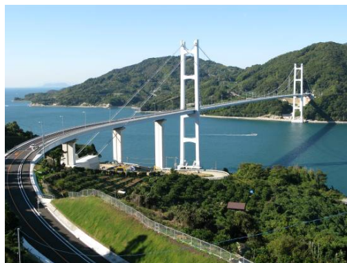
写真-2 豊島大橋全景
