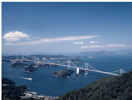
写真-1 来島海峡大橋 (1999年完成)
