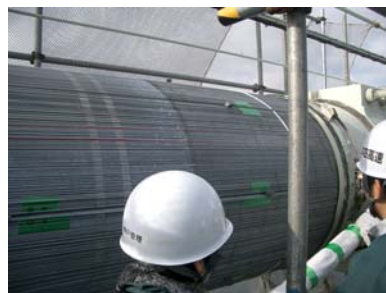
写真-2 開放後のケーブルの状況 (Photo.2 A internal inspection of a cable of AKB)
