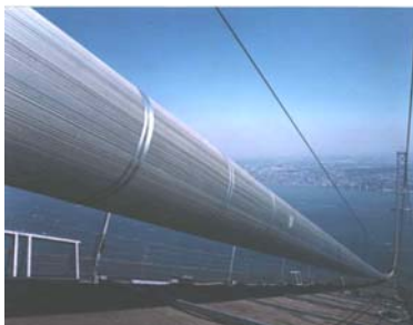
写真-1 建設中のケーブル (Photo.1 A cable during construction)
