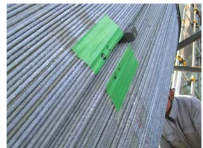
写真-2 開放後のケーブルの状況 (Photo.2 A internal inspection of a cable of AKB)
