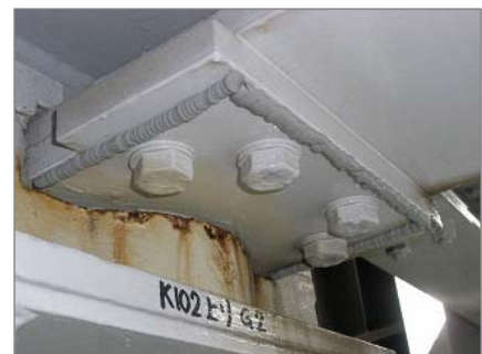
写真-3 コーキング (Photo 3: Caulking on upper bearing)
