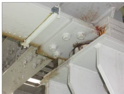
写真-2 水切り板 (Photo 2: Water stop bar)
