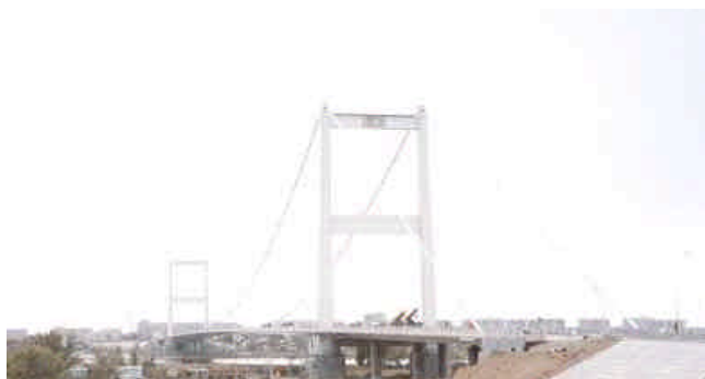
イルティッシュ河橋梁 Irtysh River Bridge
