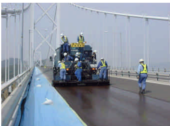
マイクロサーフェシング工法(因島大橋) Micro-Surfacing Method on the Innoshima Bridge
