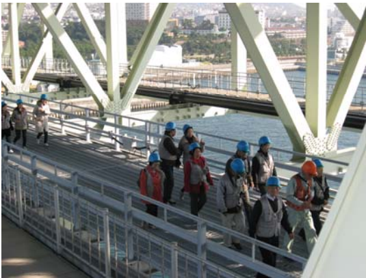
桁内管理路を歩行、格子状の床面から 足下の海が見える
