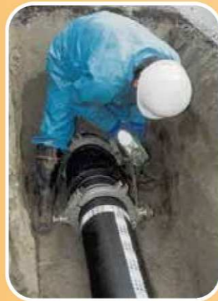
(耐震管の布設による管路の耐震化)
