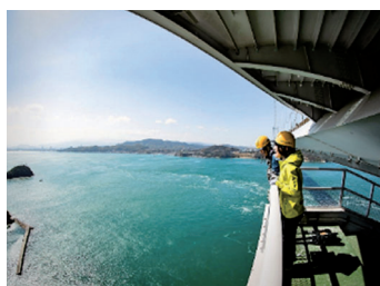
来島海峡大橋桁外面作業車乗車体験
