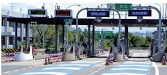
入口ETCレーンの改良（複数化）（坂出IC）
