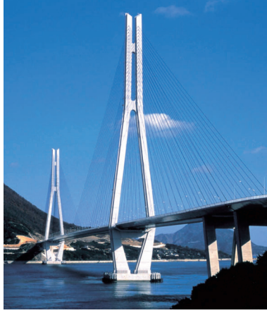
多々羅大橋
