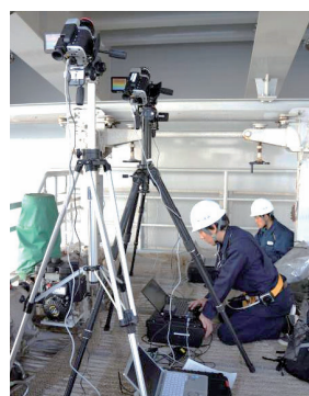
神戸大学との共同研究 (鋼床版の疲労点検)
