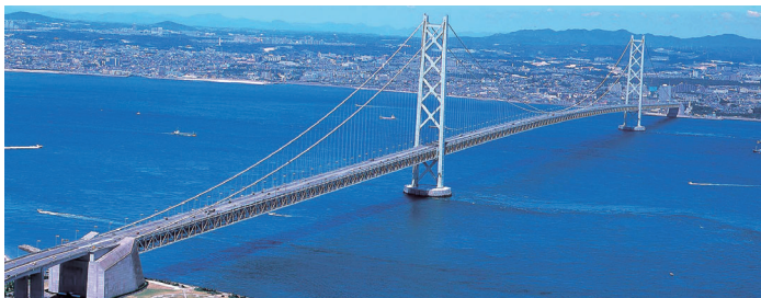
明石海峡大橋
