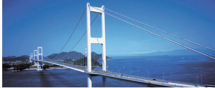
来島海峡大橋
