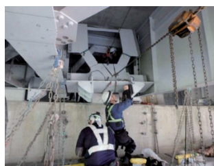
耐震補強工事 (水平力分担構造設置工)
