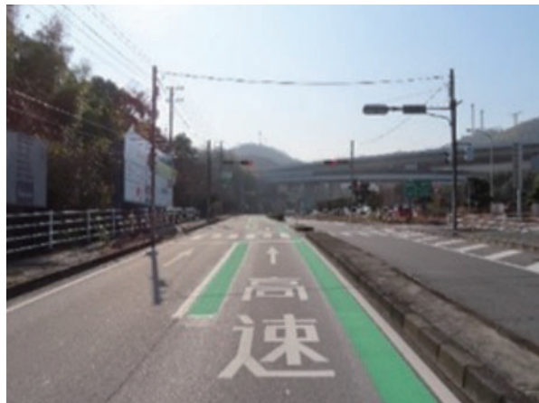
一般道誤進入対策（路面標示）
