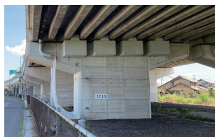
西田高架橋（岡山県倉敷市）
