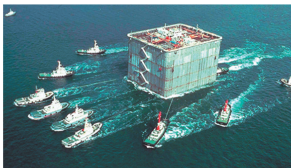
設置ケーソン工法 - 曳航（瀬戸大橋）
