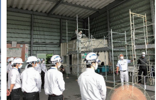
外部研修会（仮設足場）
