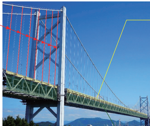
ハンガーロープ防食内部充填工法
