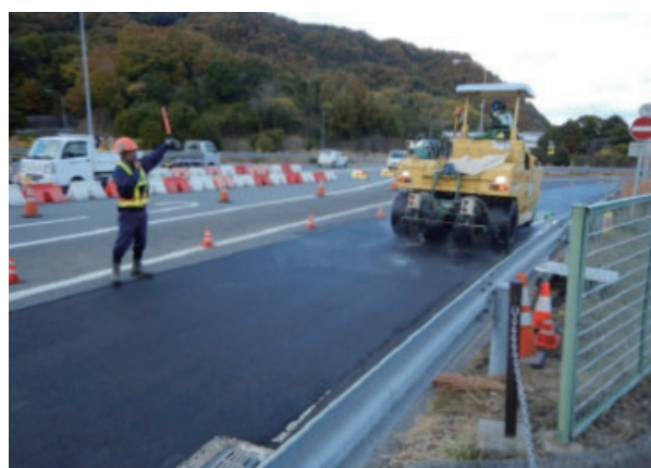
舗装補修工事状況 (E76 西瀬戸自動車道 向島 IC)
