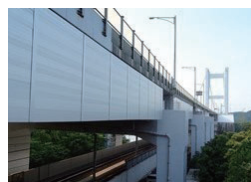
アルミ合金パネルを用いた 橋梁表面保護対策
