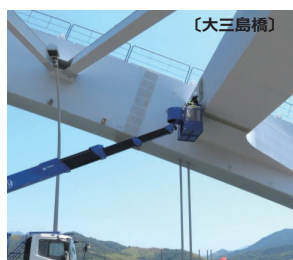
アーチ橋補修塗装
