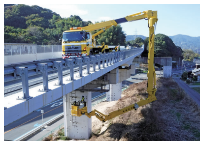
橋梁点検状況 (E76西瀬戸自動車道橋 第三伊方高架橋)
