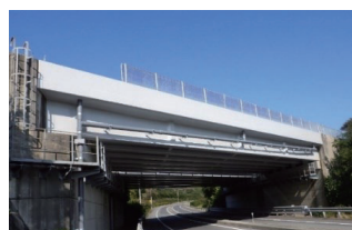
橋梁コンクリート表面保護対策
