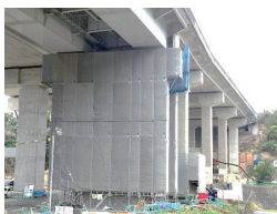
奥畑川橋（兵庫県洲本市）
