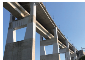
与島高架橋（香川県坂出市）
