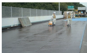
橋梁高性能床版防水
