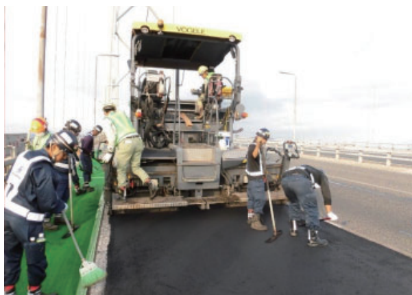
舗装補修工事状況 (E28 神戸淡路鳴門自動車道 垂水 IC～淡路 IC)
