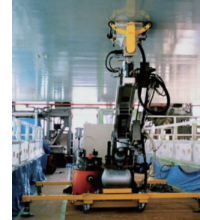
箱桁用塗装装置による塗装
