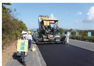
アスファルト舗装の補修
