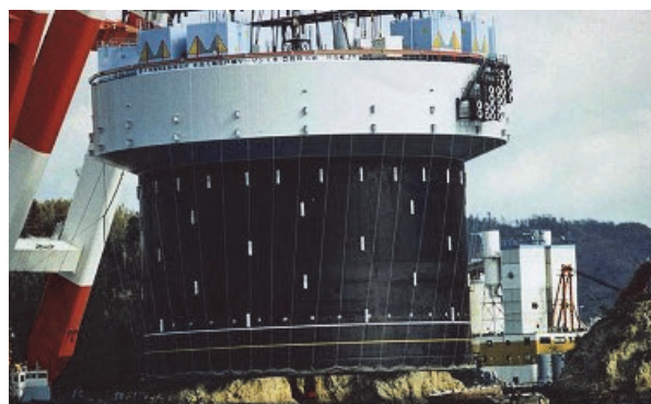
予めアルミニウム陽極を取付けた鋼ケーソン
