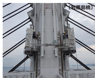
斜張橋塔塗替塗装
