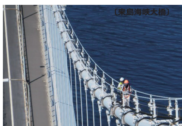
吊橋ケーブルの点検
