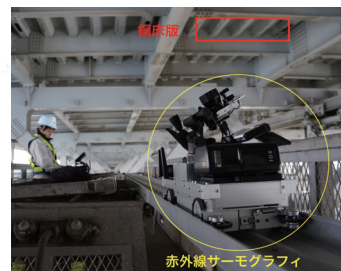
鋼床版の疲労亀裂点検
