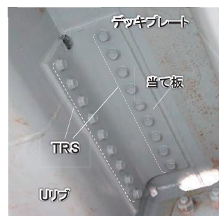
鋼床版の下面からの亀裂補修
