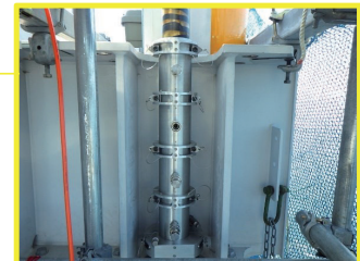
ハンガーロープ防食内部充填工法
