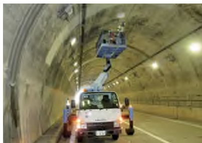
トンネル点検状況 (E28神戸淡路鳴門自動車道 撫養トンネル)
