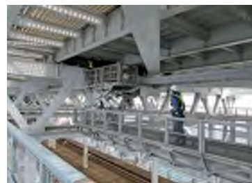
点検補修作業車による点検状況 (E30瀬戸中央自動車道 南備讃瀬戸大橋)
