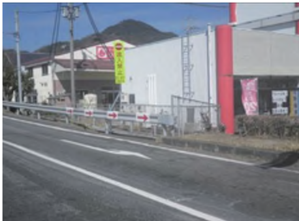
出口部誤進入対策（進入禁止板・矢印板）
