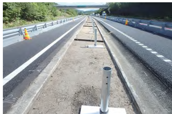
車線規制状況（防護柵改良工事）
