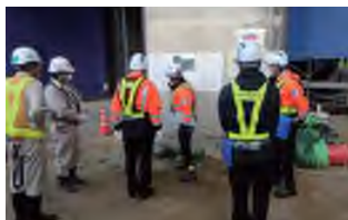
工事安全パトロール
