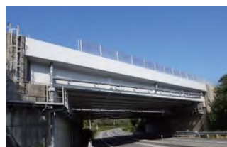
橋梁コンクリート表面保護対策
