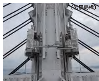
斜張橋塔塗替塗装
