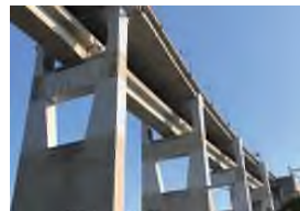
与島高架橋（香川県坂出市）
