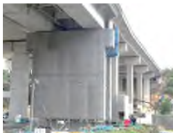
奥畑川橋（兵庫県洲本市）
