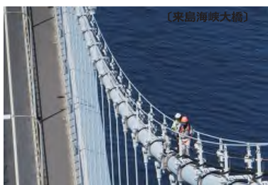
吊橋ケーブルの点検
