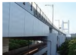
アルミ合金パネルを用いた 橋梁表面保護対策
