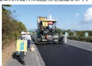
アスファルト舗装の補修
