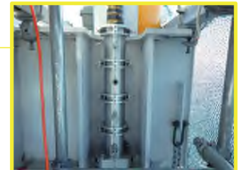
ハンガーロープ防食内部充填工法
