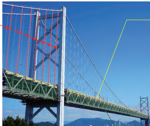
ハンガーロープ防食内部充填工法
