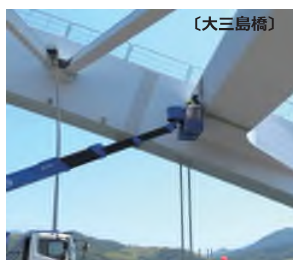
アーチ橋補修塗装
