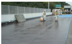
橋梁高性能床版防水
