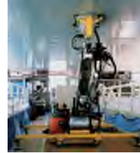
箱桁用塗装装置による塗装
