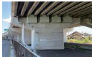
西田高架橋（岡山県倉敷市）
