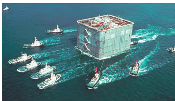
設置ケーソン工法 - 曳航（瀬戸大橋）
