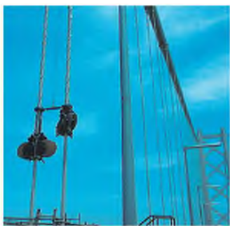
ハンガーロープ制振対策工事の状況
