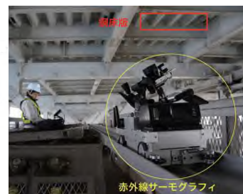
鋼床版の疲労亀裂点検
