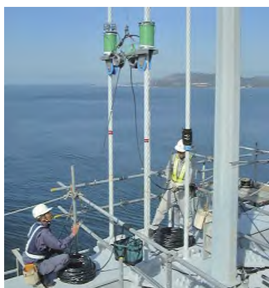
現地計測状況
