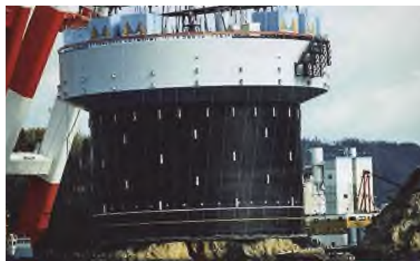
予めアルミニウム陽極を取付けた鋼ケーソン
